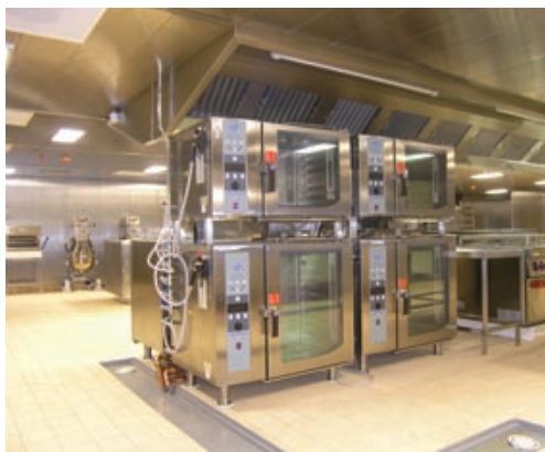
Zastosowanie stali nierdzewnej zarówno na urządzenia kuchenne jak i powierzchnie do przygotowywania jedzenia w nowoczesnych kuchniach przemysłowych. Zdjęcie: Caterform
